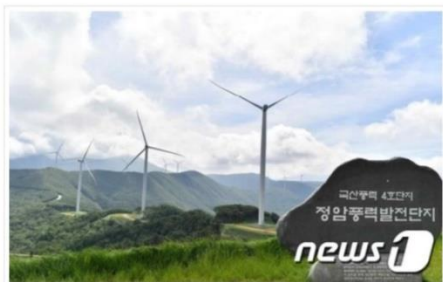
강원도 정선 해발 1400m 만항재에 건설한 남부발전의 정암풍력발전단지 전경. (남부발전 제공) © 뉴스1
