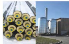
Zwei 50 m³ Wärmespeicher, 5,5 km Nahwärmenetz für 145 Haushalte
